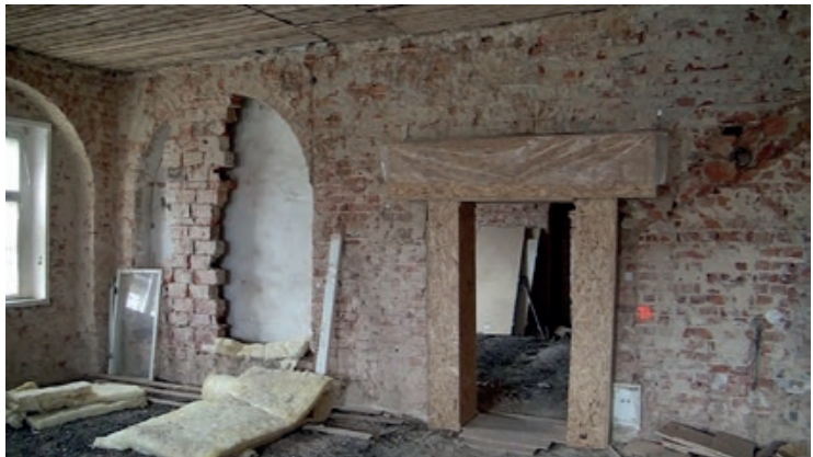
Odkrytí vnitřních omítek v 1. patře zámku v bývalé přednáškové místnosti. Nika na fotografii byla zazděna roku 1946.
